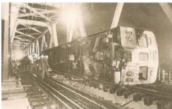
例えば 1978 年 2 月 28 日 都内を走る東西線、南砂町と西葛西の間にある荒川に架かる鉄橋を走行中の電車が春一番の強風に煽られて車体が浮上し脱線、横倒しになってあわや川に転落する寸前鉄桁でなんとかくい止めた事故がありました。東京湾から吹き込む南風をモロに受けたのです。
